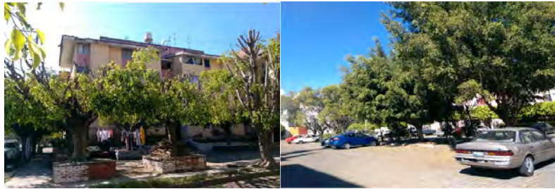
Figura 4. Espacio público interior y área de estacionamiento de la Unidad Habitacional Panorámica de Huentitán deteriorado. Fuente propia.
